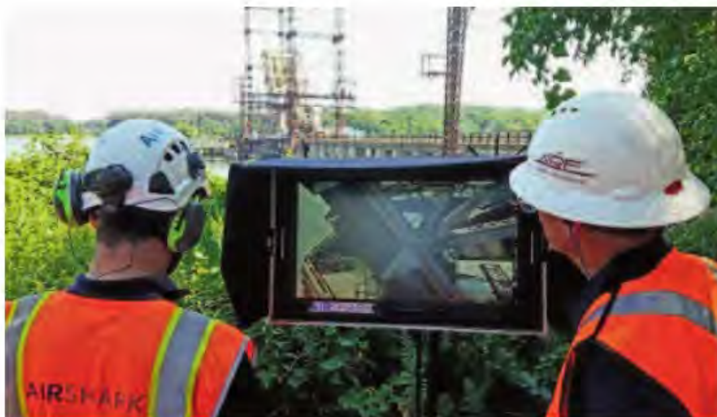
Рис. 3. Специалисты на земле контролируют работу дрона
