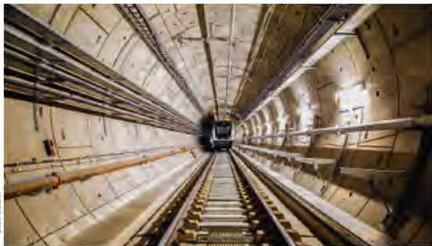
Электропоезд серии 345 Aventura в тоннеле на линии Elizabeth
