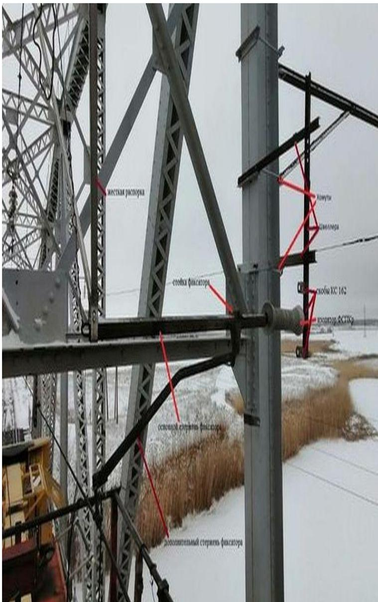
Фото 1. Устройство снижения высоты подвески контактного провода
