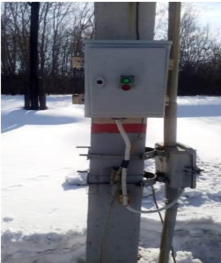
Фото 2. Устройство контроля напряжения, установленное на опору
