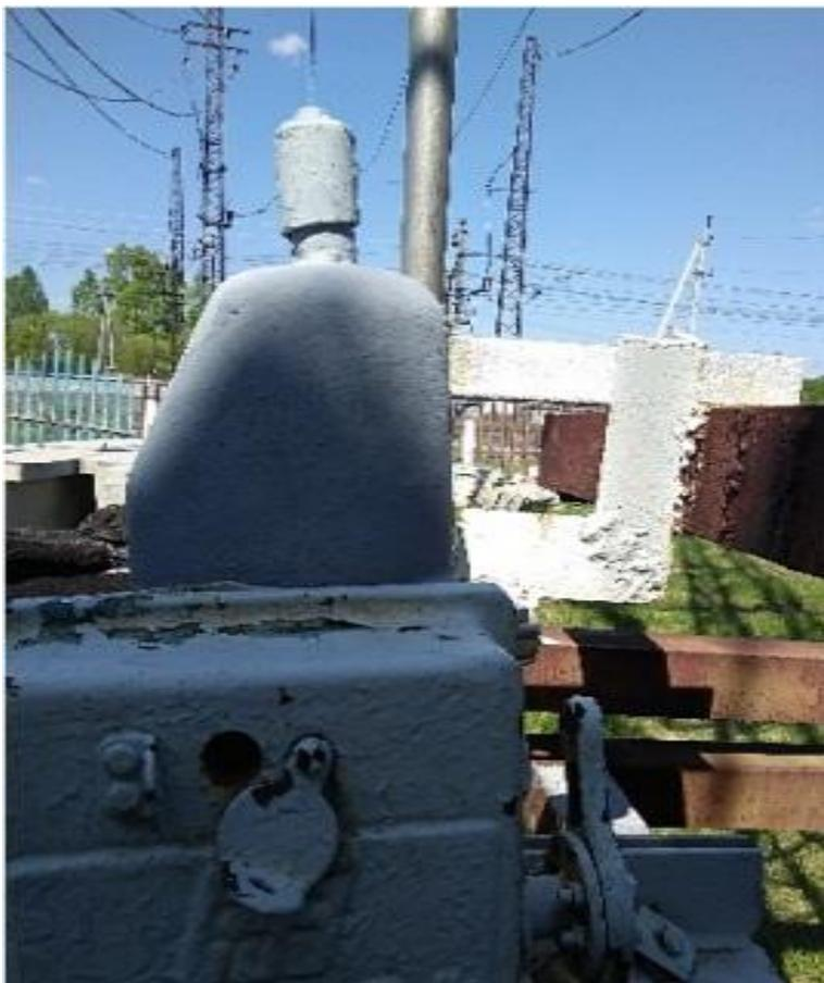
Фото 1. Модернизированный защитный колпак на моторном приводе УМП-2
