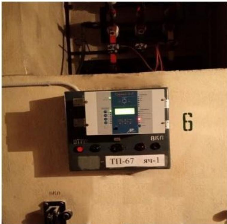
Фото. Подключение блока СИРИУС-2-Л к выключателю типа ВВ/ТЕЛ-10.
