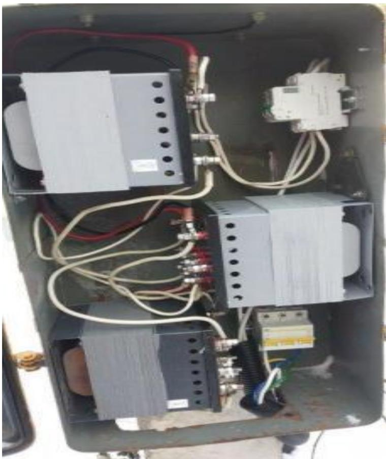
Фото. Использование разделительных трансформаторов в цепях питания осветительных установок стрелочных переводов станции.
