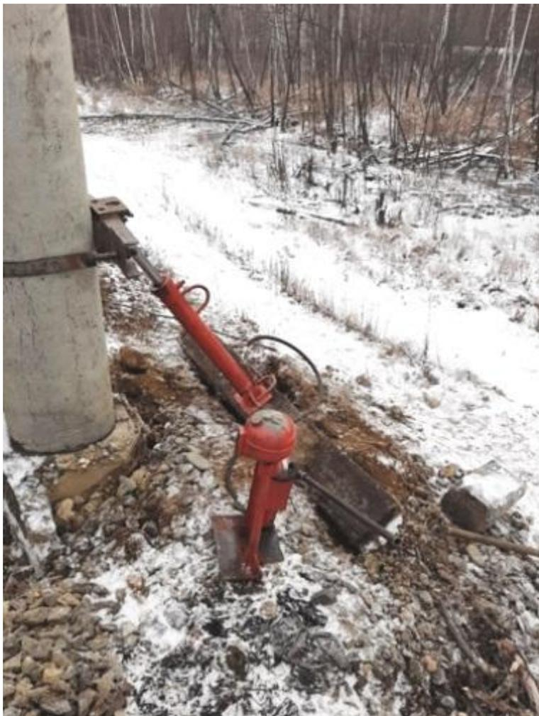
Фото 1. Общий вид устройства для выправки опор ВЛ-35/10 кВ
