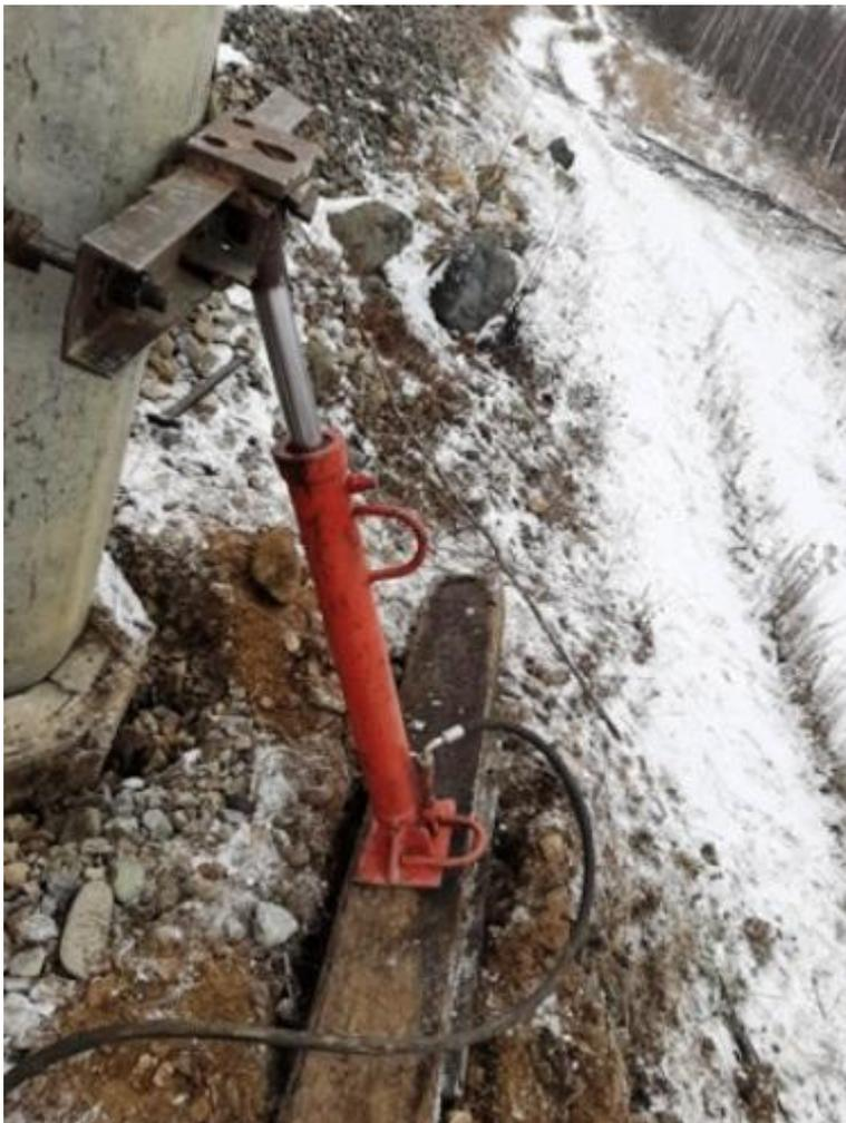
Фото 2. Гидравлический цилиндр устройства для выправки опор
