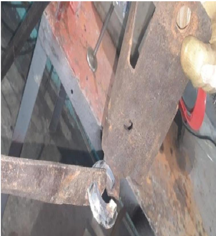
Фото 4. Фиксатор опирается на усиленную часть стойки
