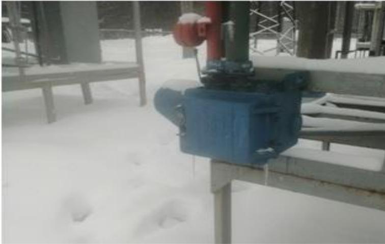
Фото 3. Привод после модернизации.
