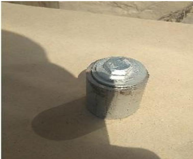
Фото 4. Крышка на трубку защитного колпака
