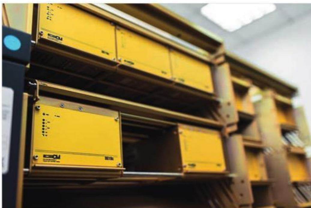
Система микропроцессорной централизации CTRL@LOCK 400
