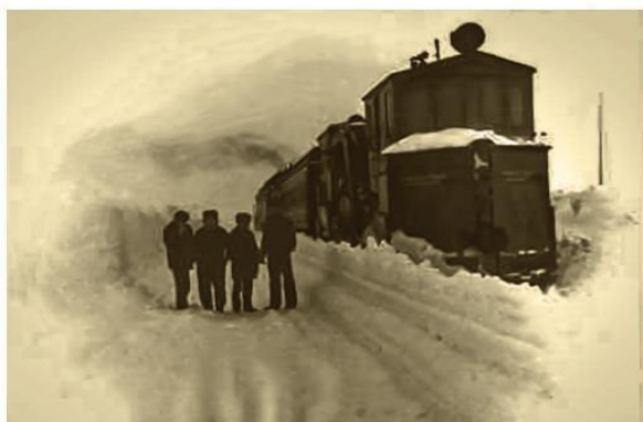
Рис. 1. Расчистка снежного заноса на 201 км. 1983 г.
